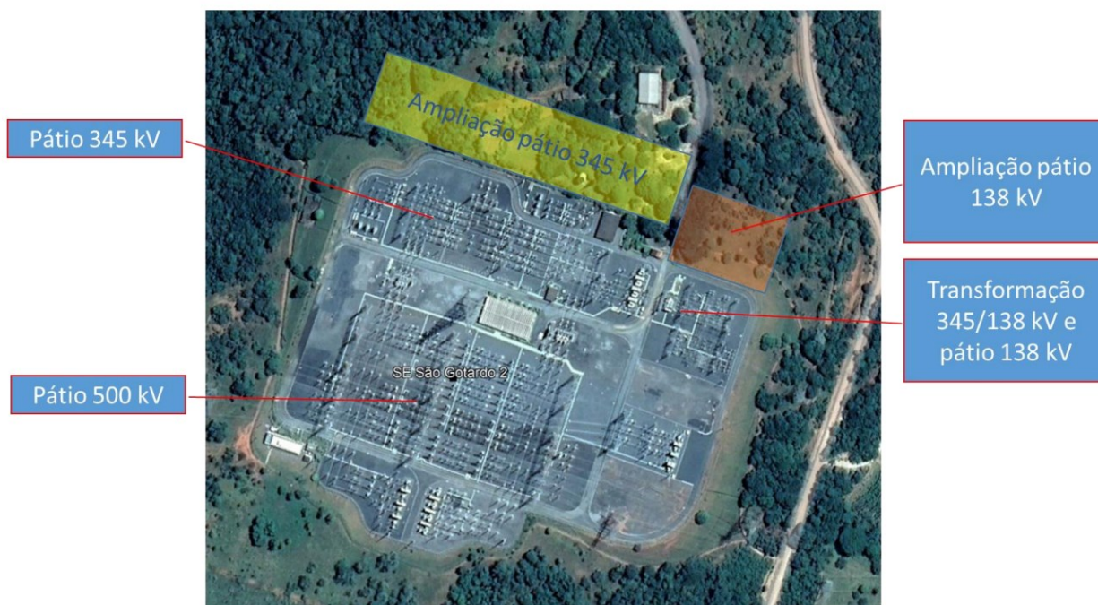
Figura 7-7 – Ampliação da SE 345/138 kV São Gotardo 2
