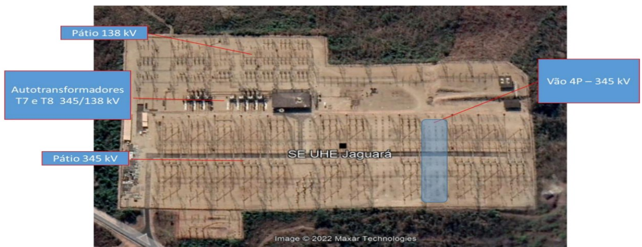
Figura 7-6 – Localização vão 4P na SE 345 kV Jaguará
